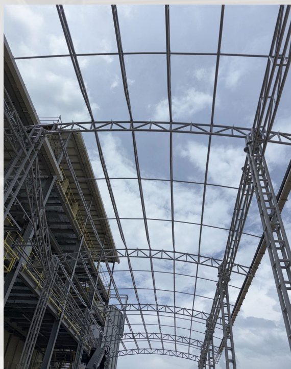
Cubierta pasillo central Planta Bioena- Fundación
