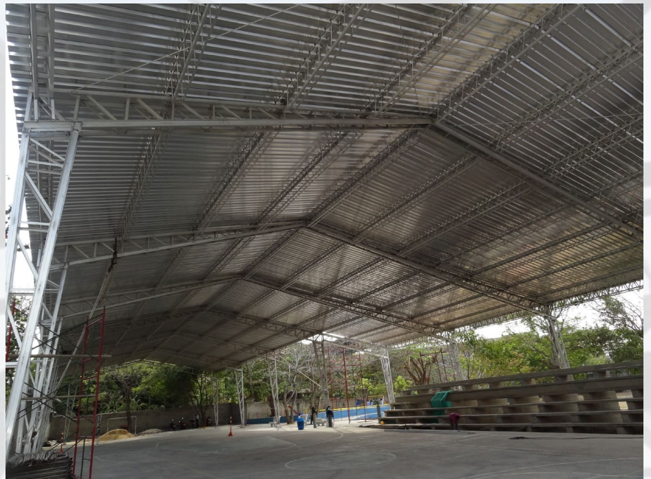
Cubierta cancha múltiple Estructura en aluminio Barranquilla
