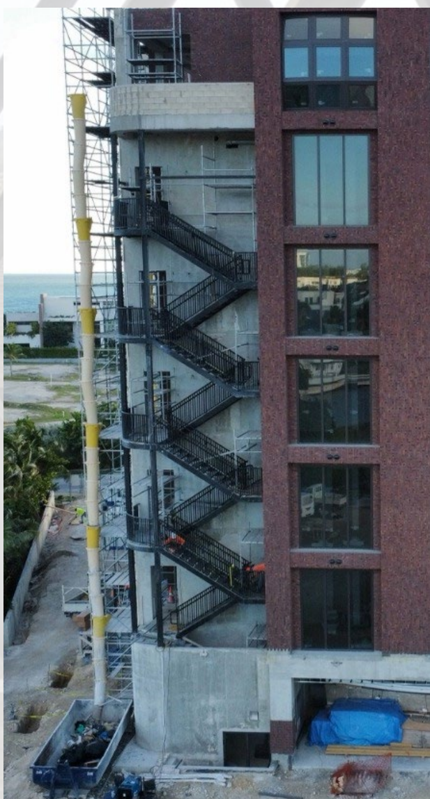
Escalera de emergencia Edificio residencial Islas Caimán
