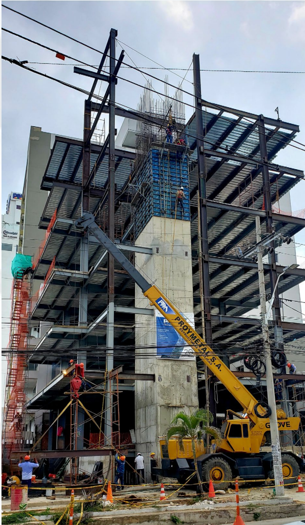
Edificio IPS Barranquilla
