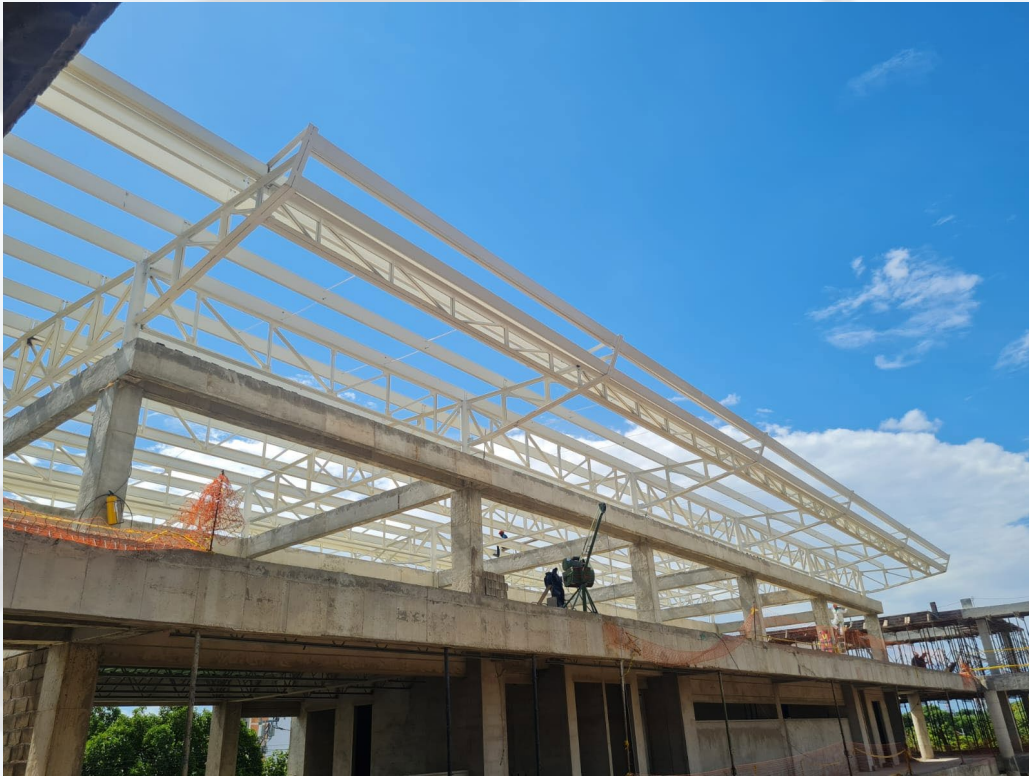
Estructura Mega Colegio Valledupar, Cesar
